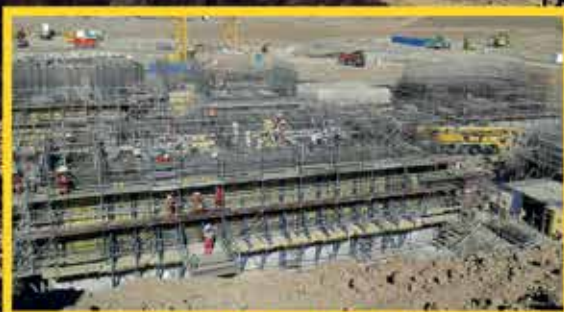
Vista general área Molienda QB2
